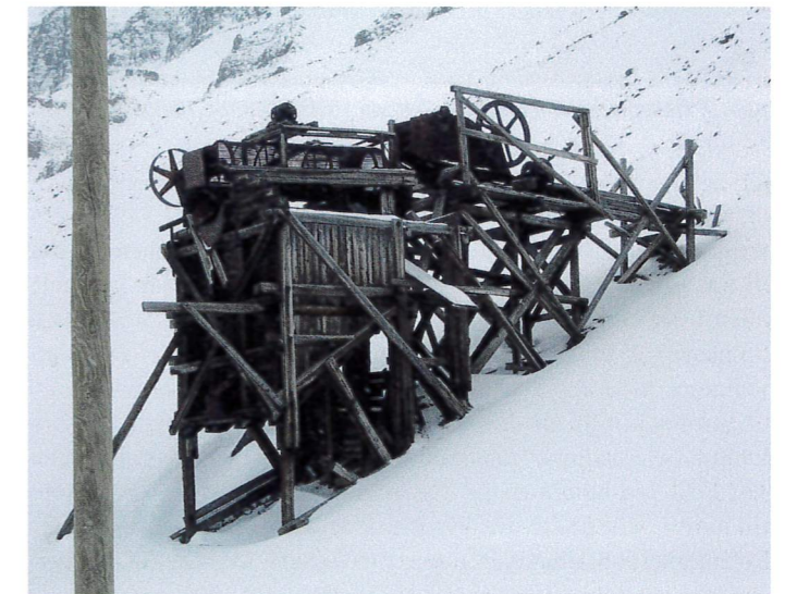
Abb. 8: Verladeanlage der Grube 1, 2016. (© Foto: Schildberg)
